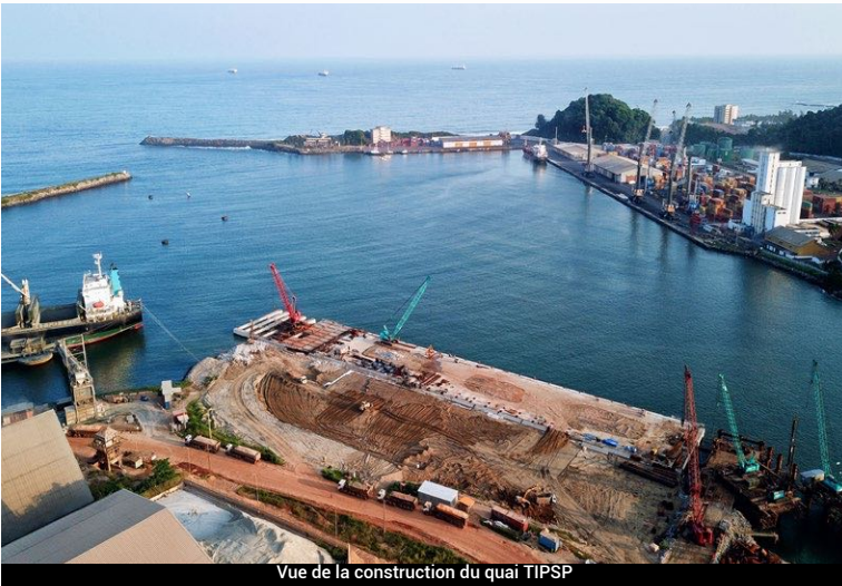
Vue de la construction du quai TIPSP
